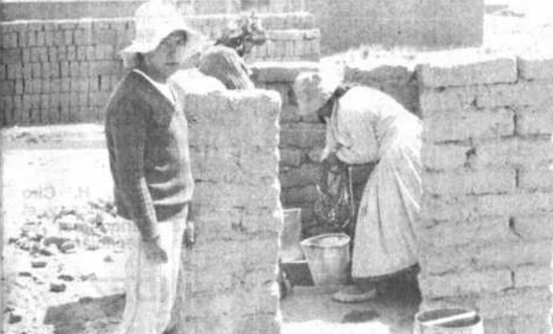
POZO DE AGUA. Los vecinos de Villa Illampu Charapaqui cavaron un pozo once metros de profundidad, para que ochenta familias de esa zona puedan abastecerse de agua. La falta de piletas públicas preocupa a los vecinos, quienes utilizan aguas servidas para la elaboración de adobes, destinados a la construcción de la escuela de la zona.
