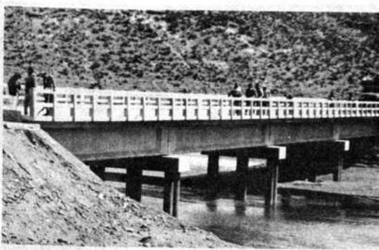
INTEGRACION.- Autoridades e instituciones locales, mantienen firme su decisión de concretar el proyecto vial Oruro-Pisaga, hacia la frontera con Chile. Con la cooperación de la Comunidad Económica Europea fueron construidos ya dos puentes sobre el río Barras. El de la fotografía corresponde al Barras I.
