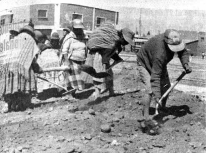
COMUNAL. De acuerdo con un informe del Departamento de Acción Comunal de la Alcaldía de El Alto, se encuentran trabajando 1.550 desocupados en más de 29 obras que realiza ese departamento. Los que trabajan reciben alimentos de acuerdo con el convenio que firmaron la Alcaldía y ADRA.
