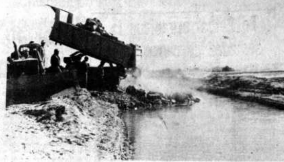
CONSTRUCCION. La construcción de badenes y plataforma de la futura carretera Oruro-Pisaga, demanda labor intermitente. Este año, la Comunidad Económica Europea, dedicó equipo pesado y contrató camiones de alto tonelaje, para la construcción de la plataforma, cuyo mantenimiento recomiendan las autoridades, a los transportistas del occidente orureño.
