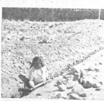
TRABAJOS.- Los vecinos de la calle 1 de Villa Exaltación realizan trabajos de excavación para la instalación de cañerías que les permitirá contar con agua potable a domicilio.
