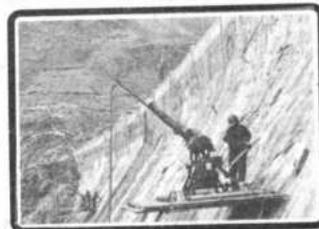
**ADUCCION HAMPATURI-PAMPAHASI.** Instalación de tubería de FFD de 800 mm. de diámetro en una extensión de 14.000 mts., entre la presa Hampaturi y la Planta de Tratamiento de Pampahasi, en sustitución del canal abierto construido en los años 1940, costo 8.8 millones de dólares financiado con préstamo del BID y recursos de SAMAPA
