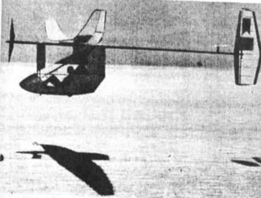
**AGUILA LIGERA.** En la fotografía se observa el primer vehículo volador impulsado por propulsión muscular. Ha logrado recientemente un límite de distancia, récord mundial, recorriendo 60 kilómetros, vuela sólo con el movimiento imprimido por un piloto que pedalea el avión. Por su creación, los proyectistas de Pasadena, doctores MacCreedy y Lissaman recibieron un premio de 100.000 dólares ofrecidos ya en 1959 a quien crease y realizase la proeza.
