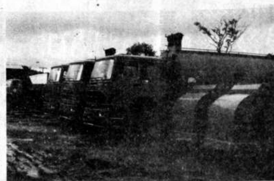
MAQUINARIA. Santa Cruz, (PRESENCIA). Parte del equipo que será utilizado en la pavimentación de la carretera Santa Cruz - Trinidad se encuentra en esta ciudad. Los trabajos se iniciaron primero desde Trinidad (Foto PRESENCIA - Santa Cruz).
