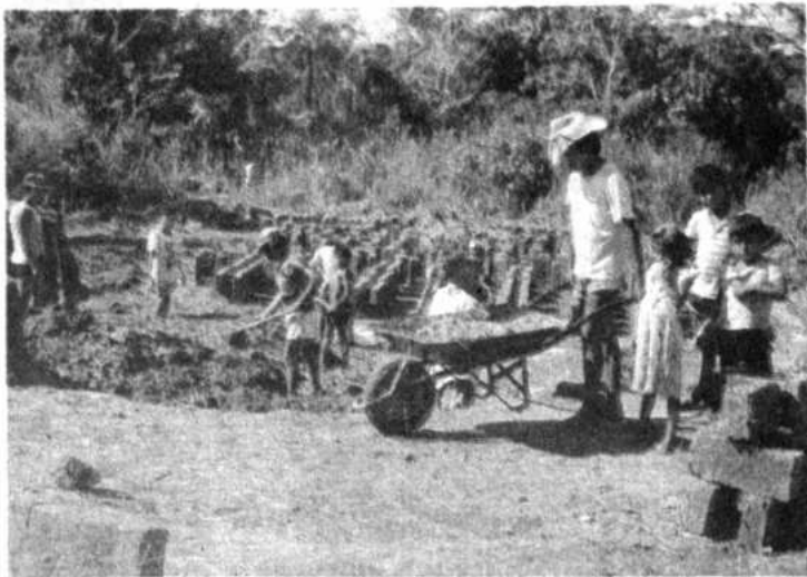
TRABAJO COMUNITARIO.- CONCEPCION (PRESENCIA).- Varias comunidades campesinas de la provincia Nullo de Chávez, han sido movilizadas por la Iglesia Católica para emprender la construcción de aulas escolares, arreglo de caminos, construcción de templos y otras obras sociales. El Vicariato Apostólico hace tiempo que motiva la práctica tradicional de la "minga" (hoy por ti mañana por mí). Campesinos chiquitanos (foto) hacen adobes para levantar una escuela rural. - (Foto PRESENCIA - Santa Cruz).
