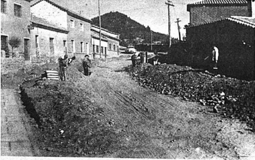
Calle Destacamento 317 en la que se efectúa actualmente el trabajo de vaciado de aceras para posterior pavimentación de calzadas.
