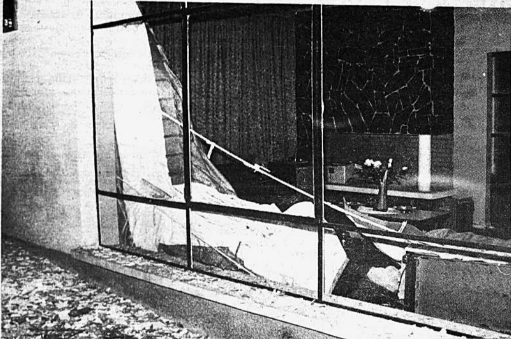
Serios daños causó a la casa del ex-Ministro, el acto terrorista de la madrugada de ayer.
