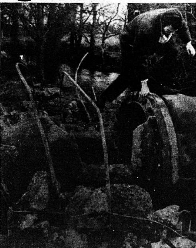
IRLANDA DEL NORTE. — Un hombre trepa sobre un tubo conductor de agua que fue dañado en Lough Neagh, cerca del aeropuerto de Belfast, después que una explosión producida por sabotadores voló una parte del mismo, cortando el suministro de agua a Belfast.— (AP Wirephoto).
