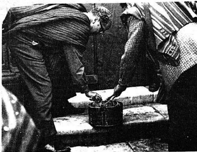
Momento en el que el Vicepresidente de la Nación inicia los trabajos de remodelación.
