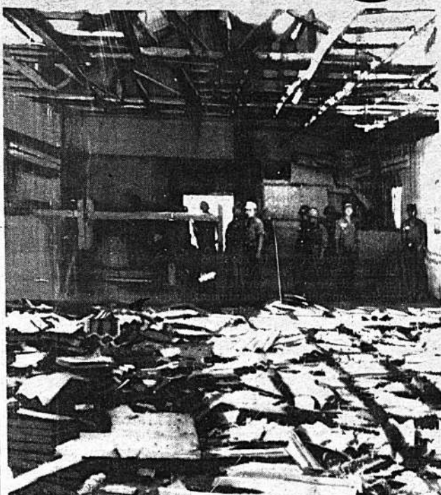
DAÑO EN CUARTELES.— Interior de un cuartel de entrenamiento de Vietnam Sur, mostrando los daños causados por los morteros enemigos y zapadores vietcong. El sorpresivo ataque vietcong a Lam Son Camp, cerca de Nha Trang, dejó 46 muertos y 137 heridos. Solamente dos vietcong murieron al abandonar el cuartel.— (AP Wirephoto).
