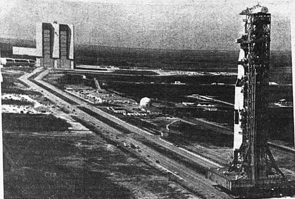
CABO KENNEDY.— El edificio de ensamblaje de todo el vehículo Apolo 10 se ve a la izquierda, mientras que el andamio que sostiene el cohete Saturno V y la nave espacial Apolo 10 avanza por la superpista, a paso de tortuga. Esta plataforma móvil de lanzamiento, que pesa 12 millones de libras, transporta el cohete Saturno V que pesa 12.500.000 libras, hasta la plataforma de lanzamiento del complejo No. 39 en la Base Espacial Kennedy.
