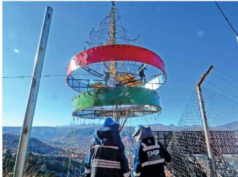
TRABAJO. Dos trabajadores municipales instalan la tea en el Parque Mirador La Paz.
