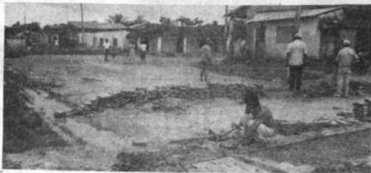
REENLADRILLADO. La Alcaldía Municipal de Trinidad dispuso la reparación del enladrillado de la esquina de las calles Bolívar y Nicolás Suárez. Un total de 500 metros cuadrados será cambiado. Mientras tanto, la población espera que similar trabajo se efectúe en otras vías urbanas, afectadas por el mismo problema y que causa innumerables dificultades al tránsito vehicular y de peatones. (FOTO JUCA-PRESENCIA).
