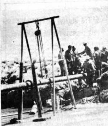
**REPARACION.** Trabajos efectuados por técnicos y obreros de SELA-Oruro, en la reparación de la tubería de aducción de agua potable de Cala Cala, sobre el río Vinto, garantizan el abastecimiento de dicho líquido a la ciudad de Oruro. El agua de Cala Cala, por su pureza, es mezclada como ablandadora, con la de Chalapatilla y Cala Caja, que suministran a Oruro agua potable.
