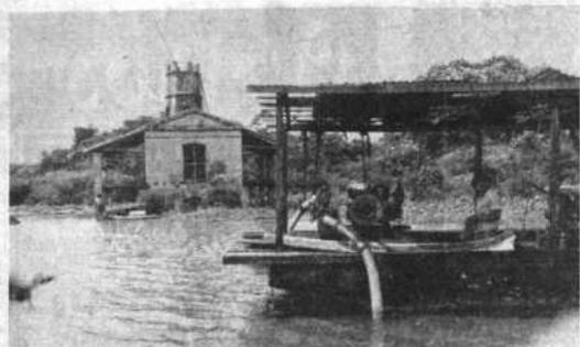
**LAGUNA "LA BOMBA".** La estación de bombeo de agua de la laguna "LA BOMBA" a 6,3 kilómetros de Trinidad, fue clausurada por AROS-Beni, después de más de medio siglo de funcionamiento. La decisión fue tomada por los técnicos en vista del peligro de contaminación constante por la rotura de la carnería de transporte.
