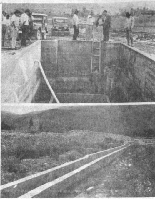
**CONVENIO, COCHABAMBA (PRESENCIA).** El Convento Boliviano Alemán hace posible un sistema de riego que evita que el agua para riego se insuma en la tierra, construyendo conductos revestidos de cemento. Se construyen en varios sectores tanques de almacenamiento. El proyecto se cumple en la provincia Punata de este departamento.
