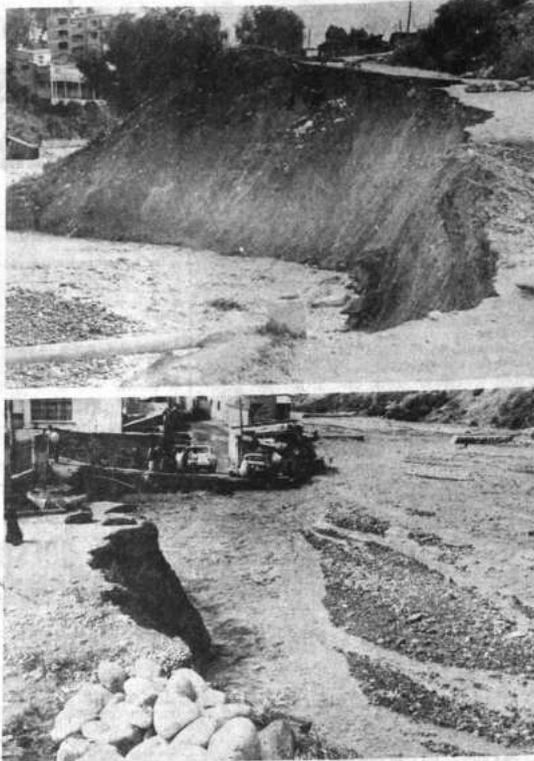
**DESlizamiento.** El crecimiento de las aguas del río Orkojuhuira provocó deslizamientos de tierra y cortó parte de la avenida Costanera que corre paralela al río en la parte baja de Villa Copacabana.
