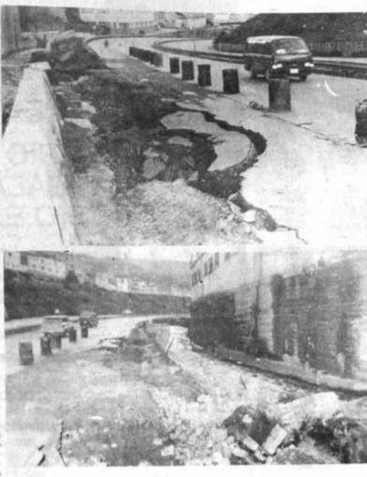
**HUNDIMIENTO.** La autopista de El Alto sufrió daños como consecuencia del deslizamiento de tierra, a la altura de la fábrica Forno. El hundimiento afectó la parte lateral de la autopista y un sector de la plataforma. Las intensas lluvias han provocado éste y otros daños en la ciudad de La Paz.
