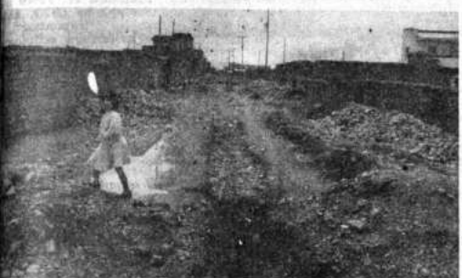
ALCANTARILLADO.- El Servicio Autónomo Municipal de Agua Abierta y Alcantarillado inició, en los sectores I, II, III de Alto Lima, la instalación de la red de alcantarillado. La primera fase de los trabajos consisten en la excavación y movimiento de tierras para proceder, posteriormente, al tendido de la tubería. El proyecto es financiado por el Fondo Social de Emergencia y SAMAPA.
