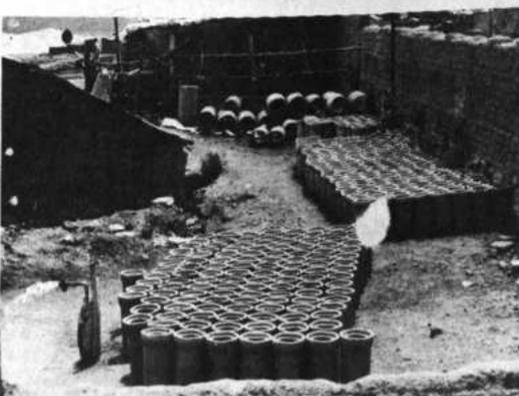
**ALCANTARILLADO.** - En la localidad de Lliallagua prosiguen los trabajos para la instalación de alcantarillado. Los tubos son fabricados en este distrito con lo que se obtiene un ahorro en los costos de trabajo.
