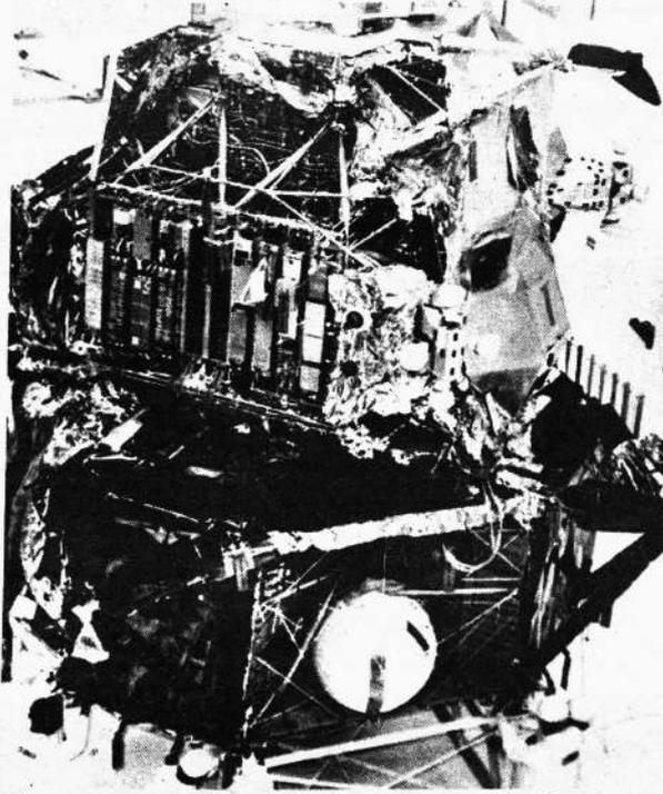
**MODULO LUNAR.**— Técnicos del Centro Espacial de Cabo Kennedy, verifican los instrumentos del Módulo Lunar, con anterioridad a su acoplamiento a los módulos de Comando y de Servicio. El lanzamiento está fijado para mañana lunes.
