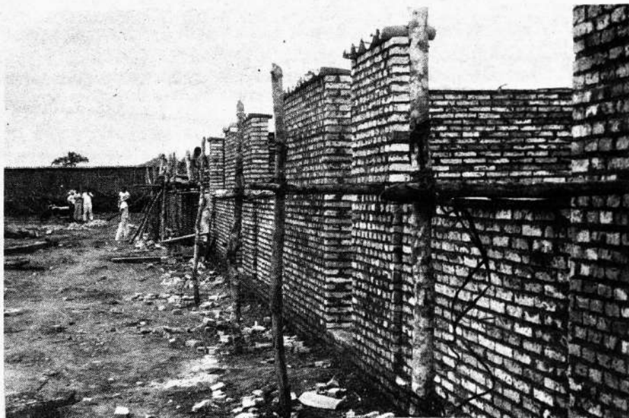
SAN IGNACIO DE VELASCO.— Vista parcial de los trabajos de construcción del moderno Núcleo Escolar que se edifica en esta localidad del departamento de Santa Cruz.
