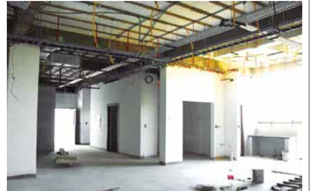
La construcción del edificio de radioterapia. JOSE ROCHA
