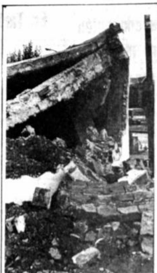
DEMOLICIÓN.- La sub-alcaldía de la zona Sud inició la demolición de una construcción clandestina ubicada en la calle 10 Esq. Ballivián, en la zona de Calacoto.
