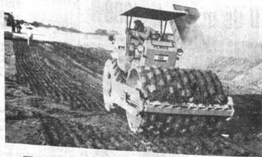
TRABAJOS EN AEROPUERTO DE YACUIBA. Continúan activamente los trabajos de construcción del nuevo aeropuerto internacional de Yacuíba. Los trabajos se efectúan en la región de Campo Grande, distante a 12 kilómetros de la población fronteriza. (Foto PKE-SENCIA-Tarija).
