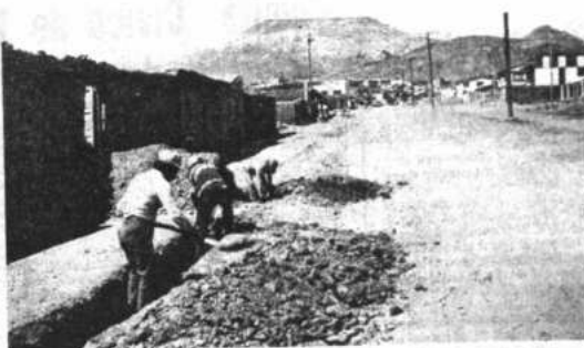
OBRAS MUNICIPALES.- Potosí, 30.- En el Nuevo Potosí, o Ciudad Satélite, la municipalidad y el Fondo Social de Emergencia, iniciaron trabajos de construcción de cordones, aceras, jardinerías y colocación de adoquines, al fondo el Cerro de Potosí (Foto PRESENCIA).
