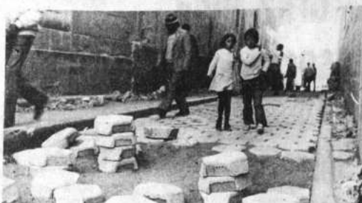
ENLOSETADO.- Potosí, 30 (PRESENCIA).- Trabajos de enlosetado en calles Junín ubicado entre calles Bolívar y Plaza 10 de Noviembre, el Financiamiento corresponde al Fondo Social de Emergencia de la Presidencia de la República. (foto PRESENCIA)
