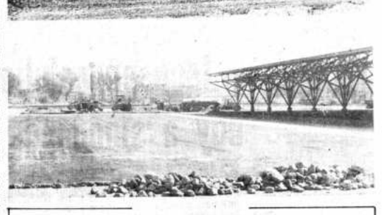
TERMINAL DE BUSES.- COCHABAMBA, 15 (PRESENCIA). CORDECO acelera los trabajos en la terminal de buses. La foto superior muestra el gigantesco galpón metálico donde se colocarán las instalaciones. Abajo, la parte oeste con los trabajos de asfalto ya concluidos (Fotos PRESENCIA).
