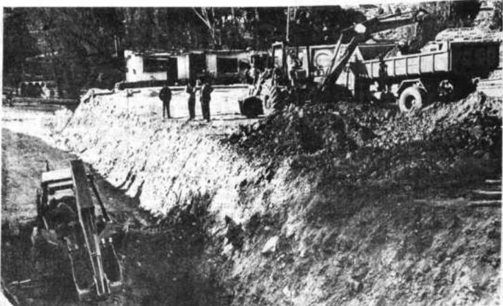
**CANALIZACIÓN.** - Bajo supervisión de técnicos municipales y de la empresa ECLA, comenzaron los trabajos de excavación en la Avenida del Ejército con el propósito de construir una variante mejorada de la canalización del río San Pedro, y un embovedado de hormigón.
