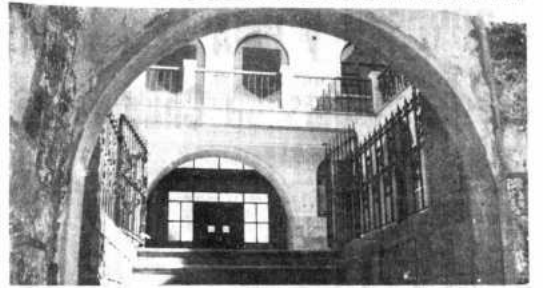
Obras realizadas por la Iglesia
