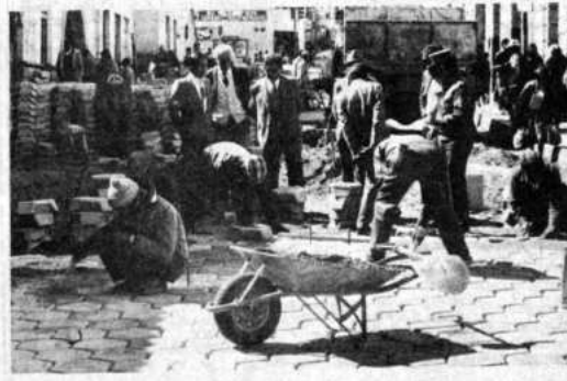
INSPECCION.- Las principales autoridades municipales inspeccionaron los trabajos de mejoramiento urbano que se realizan, en este caso, el cambio de las losetas de la céntrica calle Bolívar, en la cuadra del mercado Central de la Villa Imperial. (Foto: PRESENCIA, Potosí).
