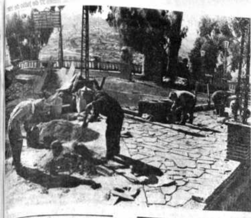
REMODELACION.- Trabajadores municipales realizan trabajos de remodelación de la plaza del Montículo.
