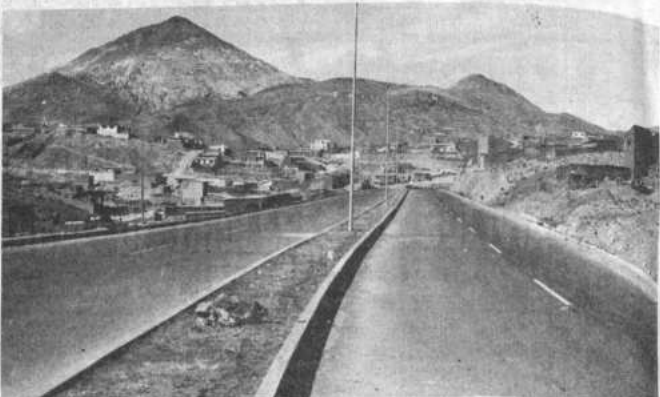
ILUMINACION. La Corporación Regional de Desarrollo de Potosí, al haber efectuado la construcción del tramo Potosí y Taparaya se preocupa en la iluminación de la avenida principal de este importante tramo carretero. Es así que con recursos propios a la fecha ha ingresado CORDEPO a la etapa de la colocación de postes. En breve tiempo serán colocadas las luminarias que darán un buen aspecto. En la foto, vista del tramo Potosí-Taparaya con la colocación de postes. Al fondo del Cerro Rico y el Cerro Chico (foto PRESENCIA-Potosí).
