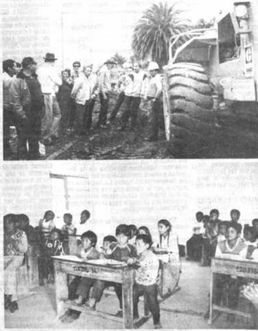
CONSTRUCCION DE HOSPITAL.- Con recursos del gobierno de Italia, comenzaron en la población de Coroico la construcción de un moderno hospital para beneficio de la población campesina de la región. En el gráfico, se observa equipo pesado que realiza la limpieza del terreno donde se iniciarán las obras. El sacerdote Camilo Ruffino, responsable del Centro Italiano de Solidaridad, tiene a su cargo el
