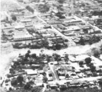
ARROYO SAN JUAN. El arroyo que cruza la capital beniana, será objeto de un estudio técnico para convertirlo en probable canal de las aguas servidas, en el proyecto de agua y alcantarillado para Trinidad. Los trabajos preliminares podrían ser financiados por el Fondo Social de Emergencia, que ya recibió la solicitud de la Corporación Regional de Desarrollo (CORDEBEN). (POTO JUCA PRESENCIA).
