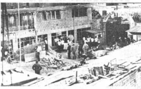
CONSTRUCCION. Efectivos policiales de Tránsito, en forma comunitaria, cooperan en la construcción de un edificio de tres plantas, en el Batallón de Tránsito, en la avenida Mariscal Santa Cruz. Según el director nacional de esa institución, Cnl. Carlos Camberos, el edificio será inaugurado en el 61 aniversario de Tránsito, el próximo 8 de junio.
