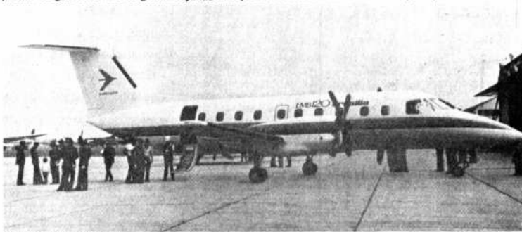
EMB-120 BRASILIA Modelo en desarrollo — Capacidad para 30 pasajeros con cabina presurizada, las nuevas turbinas Pratt Whitney PT 7A-1 logran una reducción sustancial en niveles de ruido y consumo de combustible.
