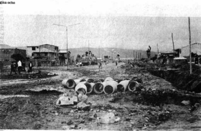
ALCANTARILLADO en los barrios marginales de la ciudad de Cochabamba. Los trabajos están terminados y sólo se espera la construcción de lagunas de alivio.
