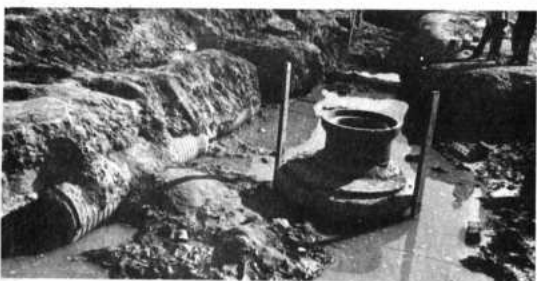
TENDIDO de tubería para la red de alcantarillado de la ciudad de Cochabamba.
