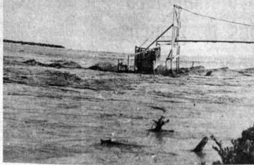
EN EXPLOTACION.- Uno de los pozos petrolíferos de YPPB. a 84 kilómetros de Santa Cruz, ha quedado cubierto por el río Grande. Los técnicos indican que la inundación no ha afectado la estructura y que su producción es normal. (Foto PRESENCIA-SANTA CRUZ).
