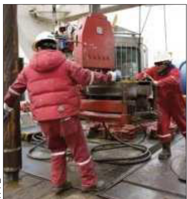
Trabajadores perforan el pozo.
