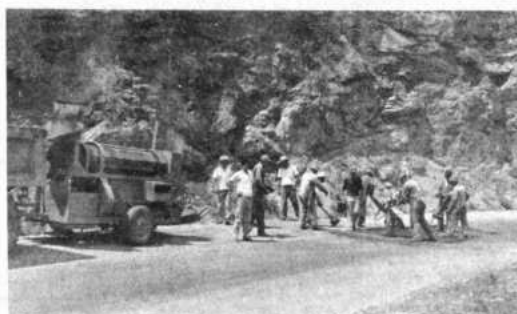
MANTENIMIENTO. Brigadas del servicio de Caminos realizan trabajos de mantenimiento, para tener en servicio la carretera Cochabamba - Santa Cruz. Sin embargo, la falta de atención oportuna hizo que esta vía se encuentre en condiciones lamentables (Foto FRANCO para PRESENCIA)
