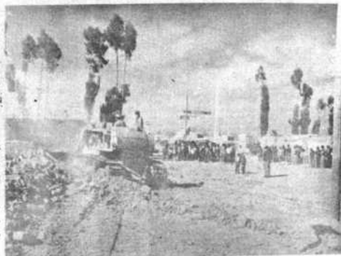
PLAN 500 Km de CAMINOS DE PENETRACION: 323 Km., construídos y 220 en construcción. En la foto, la inauguración de los trabajos de la carretera pavimentada Tolata — Cliza (Obra del Gobierno Nacional).
