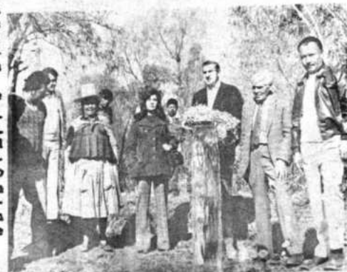
23 POZOS ARTESIANOS tipo surgente en el valle cochabambino para agua potable y regadío.
