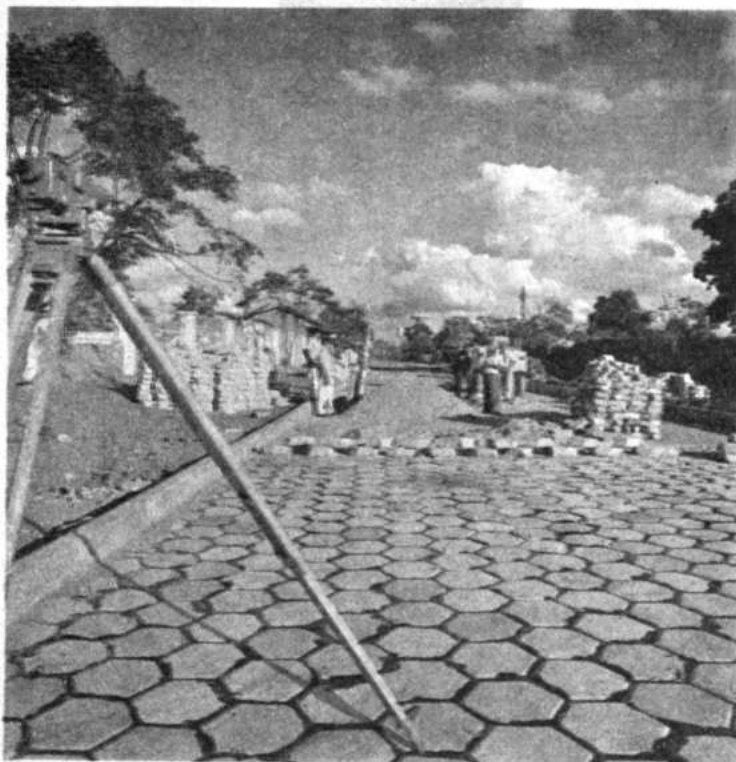
Trabajos de enlosado en Montero
