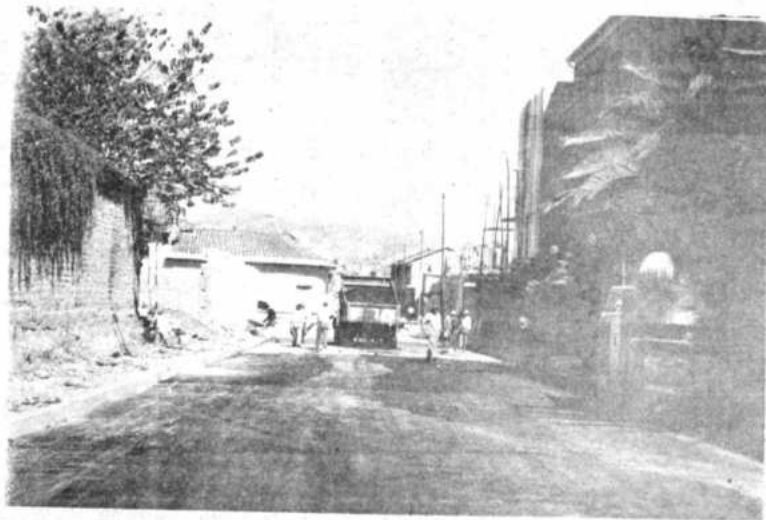
PROGRAMA DE ASFALTADO.- Las obras de pavimentación tienen su complementación con los programas de enlosado.
