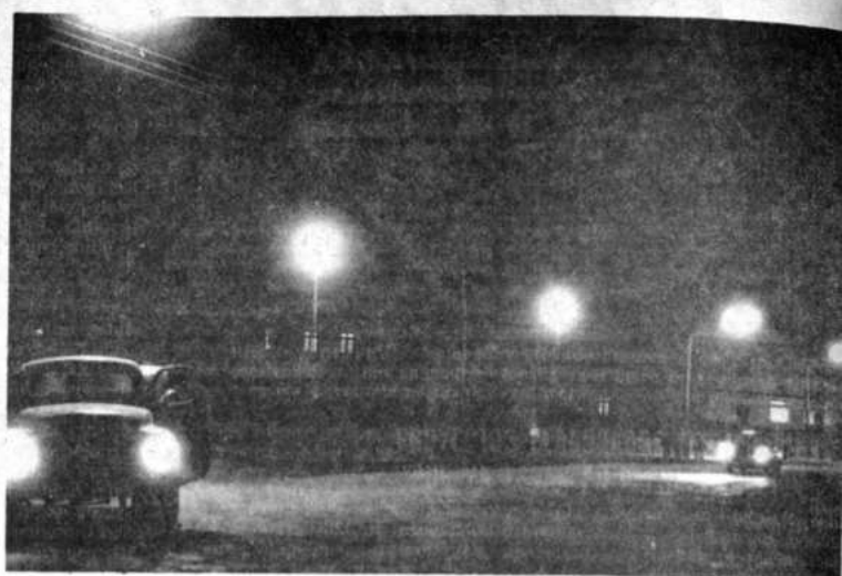
En homenaje al Sesquicentenario, Cochabamba renueva sus sistemas de alumbrado público. El programa comprende la instalación del alumbrado a vapor de sodio produciendo la "luz de oro".
