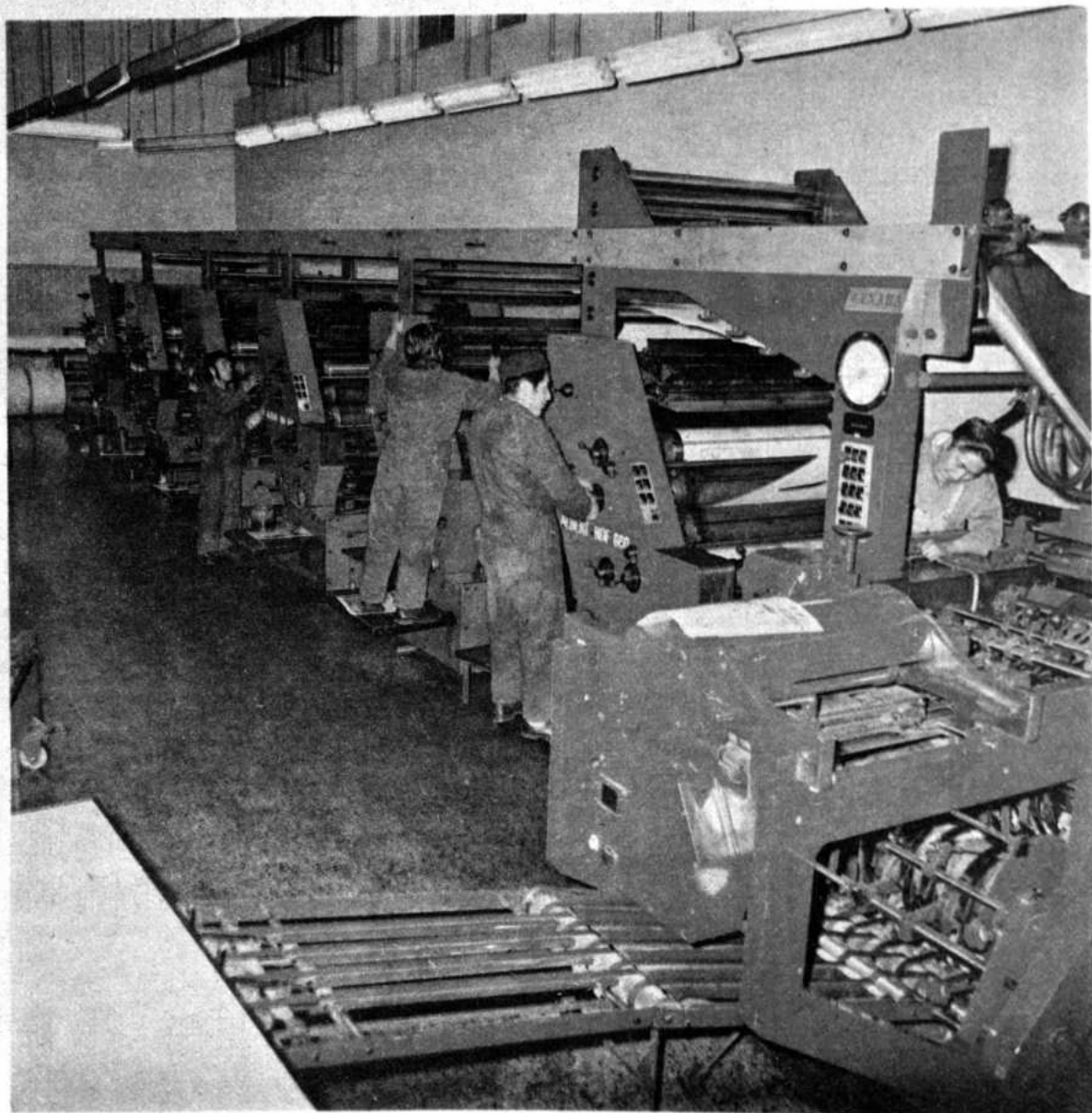
La moderna prensa "ALBERT", cuya velocidad de tiraje y precisión de registro, garantizan la calidad de las impresiones realizadas en Editorial "LUX".
