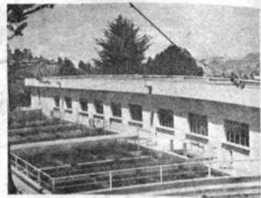
Filtros de Achachicalla, similares serán construidos en la planta de tratamiento de El Alto, por Lurgi.
