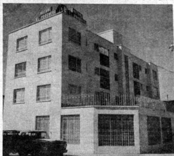
Edificio central en Oruro.
