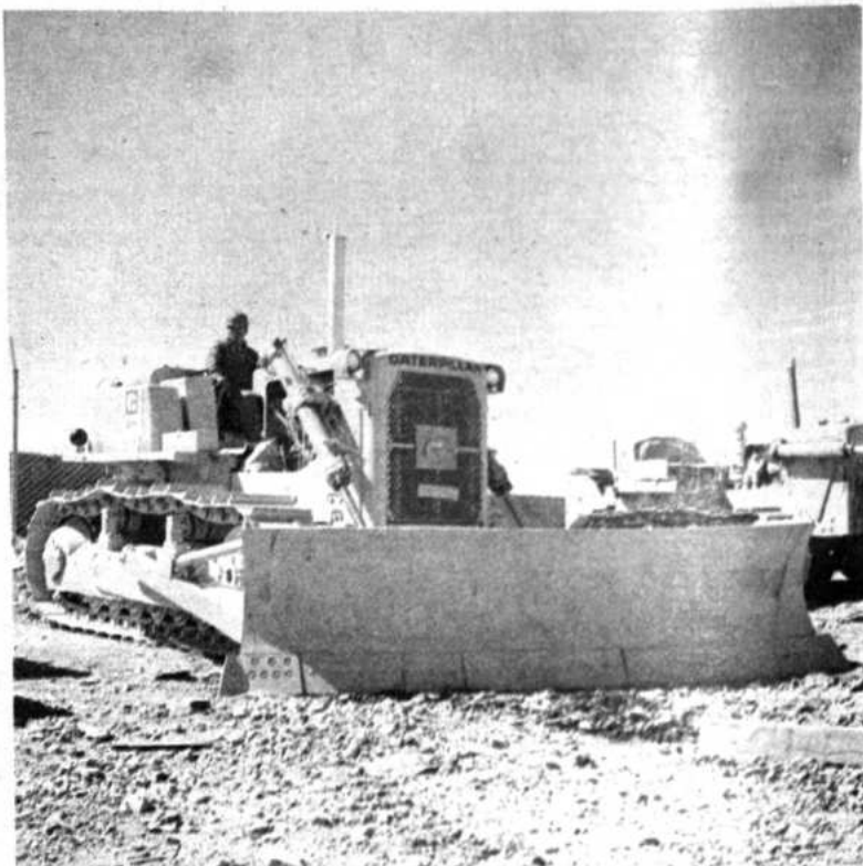
Tractores D7-F, del equipo destinado por CORDEPAZ para la construcción del camino Charazani-Apolo-Ixiámas, iniciado el 15 de julio de 1975.
