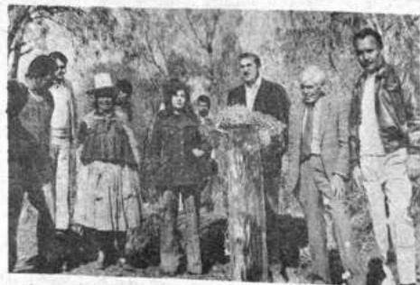
23 POZOS ARTESIANOS, tipo surgente para agua potable y regadío en el valle cochabambino.
