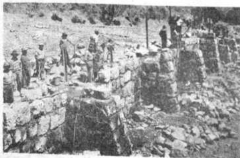
34 OBRAS de defensivos, galerías filtrantes, tajamares y captación de aguas potables.
