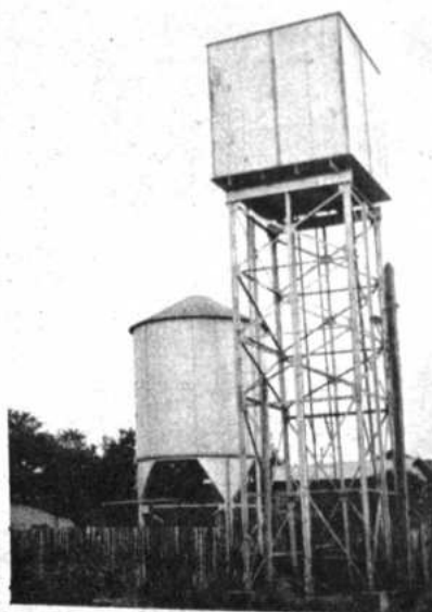
Tanques de almacenamiento
