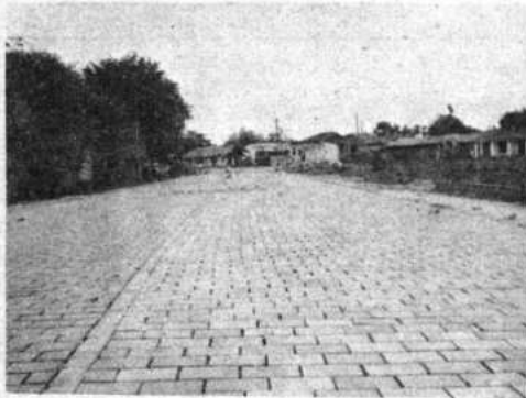
Enladrillado de la Avenida "José Chávez Suárez"
