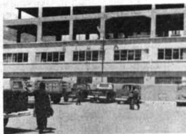
Vista parcial de las estructuras del edificio de ETOSA.
