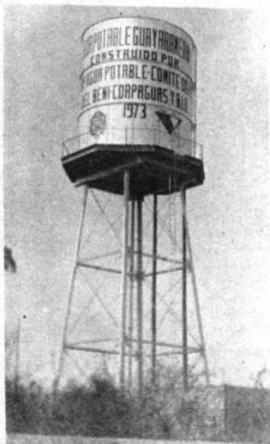
Tanque de agua de Guayaramerín
